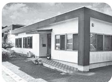
【ワークセンターあゆの里外観】
