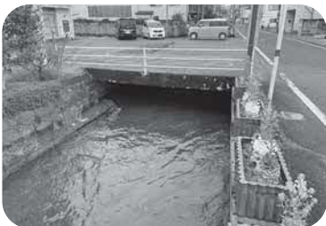
【町道東園西園線・鶴田橋】
