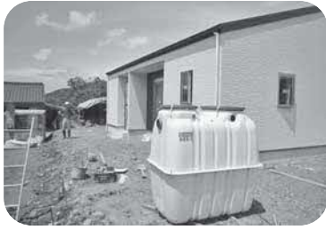
【新築住宅に設置される 合併処理浄化槽】
