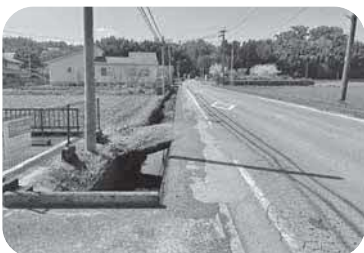
【町道津志田中山線 ガードレール】
