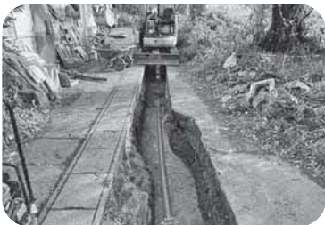
【町道府領村中線の水道管布設状況 (R4実施分)】
