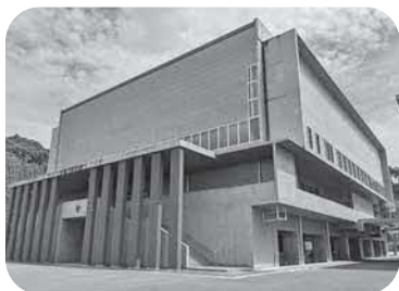
【地方債を活用し整備した 甲佐中学校体育館】
