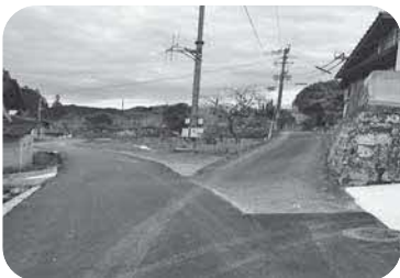
【水道管を埋設した道路 (西原区)】
