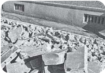
【危険ブロック塀の除去の様子】
