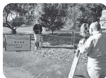
【現地での測量風景】
