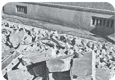
【危険ブロック塀の除去の様子】
