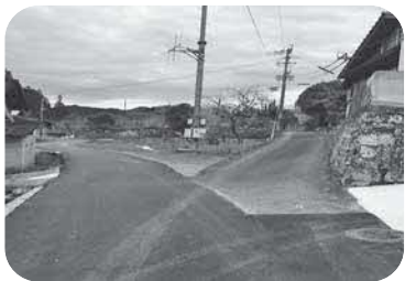
【水道管を埋設した道路 (西原区)】
