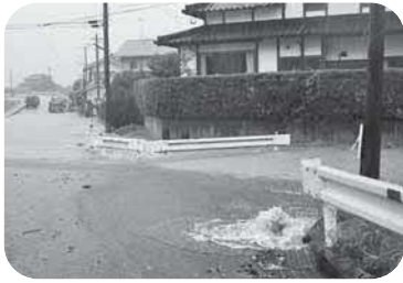
【馬門川周辺 (平成19年7月豪雨 浸水状況)】
