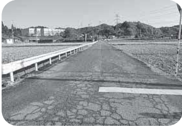
【町道中早川北早川線の現況写真】
