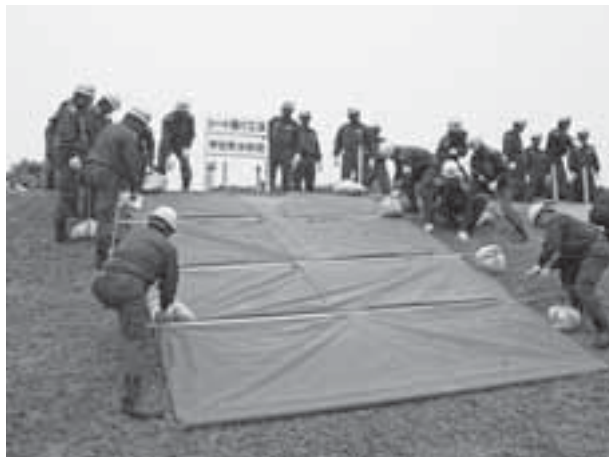
◀「シート張り工法」を実施する町水防団員ら
