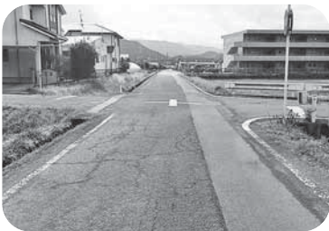
【町道下豊内有安線の現況写真】
