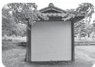
【現在の北早川地区消防格納庫】
