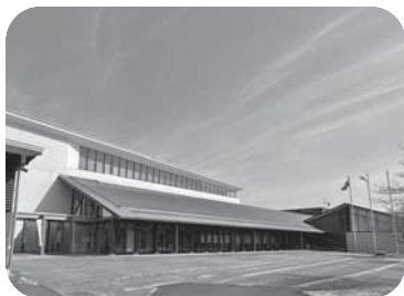
【役場庁舎および生涯学習センター】
