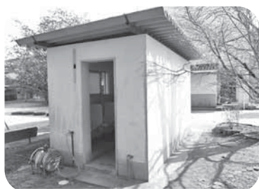
【現在の乙女小学校の屋外便所】
