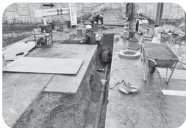
【令和3年度に実施した町道古閑八丁線の水道管布設状況】
