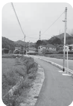
【整備された防犯灯(西寒野地区)】
