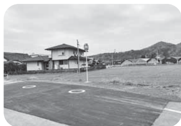
【大町地区の耐震性貯水槽】
