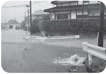
【馬門川周辺 平成19年7月豪雨 浸水状況】
