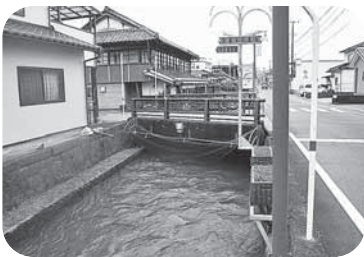
【町道東園西園線・甲北橋】
