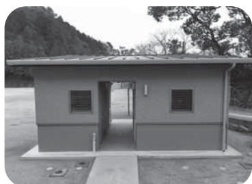
【完成した白旗小学校の屋外トイレ】
