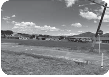
【中横田地区の耐震性貯水槽】
