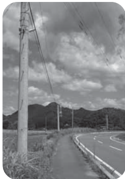
【整備された防犯灯 （西寒野地区）】
