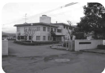
【御船地区衛生施設組合】
