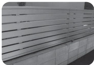
【危険なブロック塀を撤去し、新たに設置】
