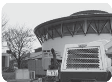
【屋上室外機の撤去作業】
