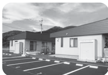
【早川第一団地の建築した2棟4戸】
