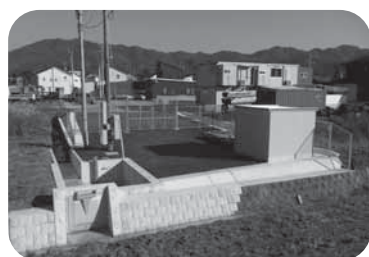
【下横田排水ポンプ場の完成写真】
