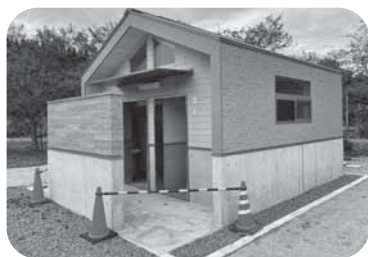
【令和3年度に整備された竜野川環境施設トイレ】
