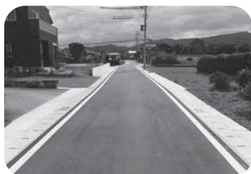
【町道早川下糸田線の竣工写真】
