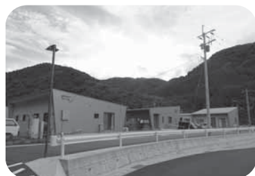
【令和3年度に完成した上揚団地3棟8戸】
