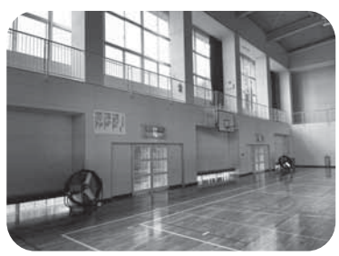
【換気設備を設置した甲佐町スポーツセンター】
