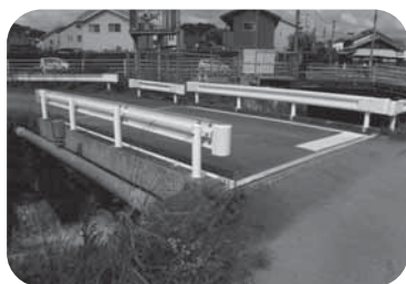
【町道大町二段橋線・二段橋】
