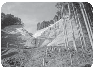
【地方債を活用し復旧した林道】
