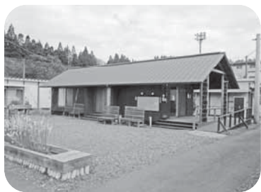
【白旗仮設団地内のみんなの家】
