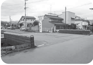
【町道東園西園線・鮎緑橋】
