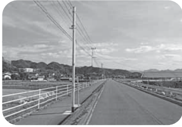
【整備された防犯灯(浅井地区)】
