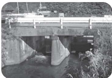
【町道下鶴塔ノ木線・塔ノ木橋】
