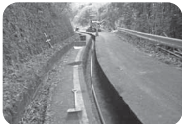
【令和元年度に実施した小鹿地区の水道管布設状況】
