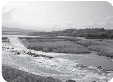
【本年度工事予定の糸田堰】
