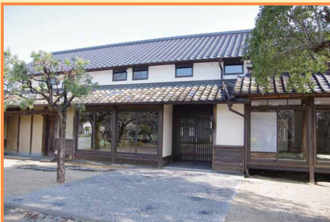
改修を行った古民家交流拠点施設（旧西村邸）
