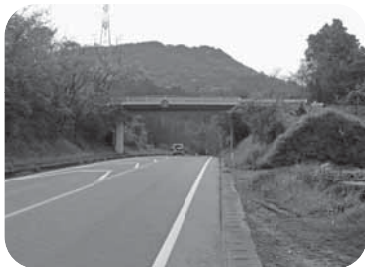
【改修予定の西寒野農道跨道橋】
