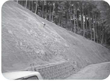
【現在復旧工事を行っている 林道本坂谷線】
