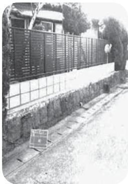
【危険ブロック塀改修例】
