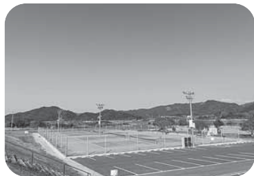
【整備された総合運動公園 テニスコート】
