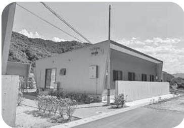
【上揚団地建替後写真 (令和2年度完了分)】
