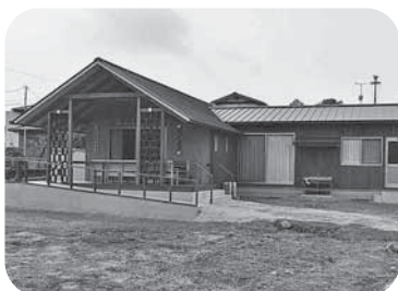
【みんなの家を再建して整備された府領公民館】
