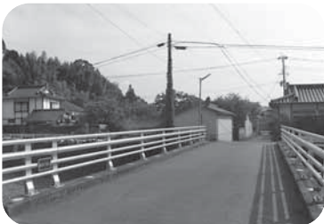
【補修工事が完了した浅井橋(浅井地区)】
