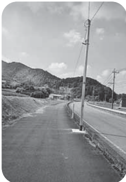
【整備された防犯灯 (中横田地区)】
