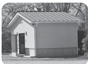
【完成した龍野小学校の外部トイレ】
