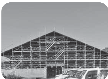
【工事用の足場に囲まれた総合保健福祉センター】
