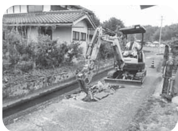
【津志田地区での農道補修の様子】
