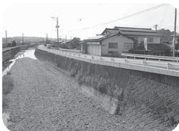
【嵩上げ工事が完了した 竜野川の護岸】
