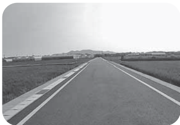
【道路改良工事が完了した町道吉田県道線】
