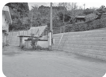
【防護施設設置状況： 宮内地区社会教育センター】
