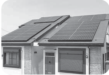
【設置されたソーラーパネル】
