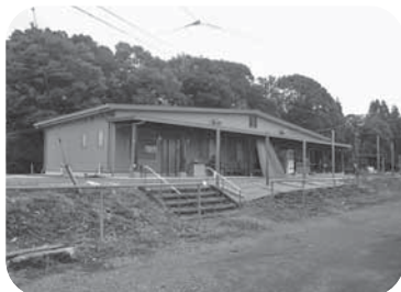
【復旧されたグリーンセンター集会用施設】
