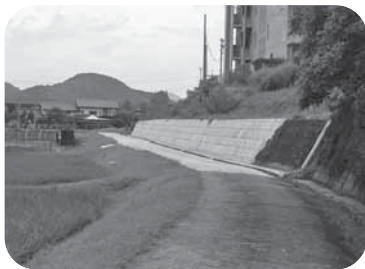
【復旧した中横田地区の甲佐中学校下の水路】
