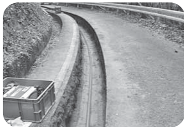
【小鹿地区の配水管布設状況】
