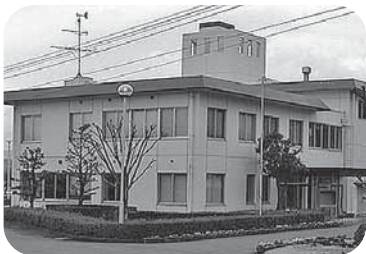
【御船地区衛生施設組合の外観】
