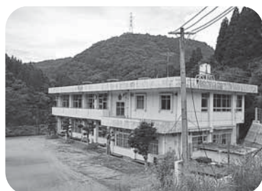
【宮内地区社会教育センター 南東側からの様子】
