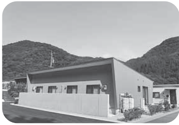
【新たに建替え工事を行った上揚団地】
