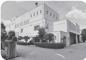
【御船町甲佐町衛生施設組合(クリーンセンター)の外観】
