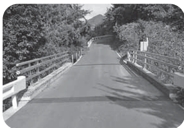
【補修工事が完了した松ノ尾橋(西寒野地内)】
