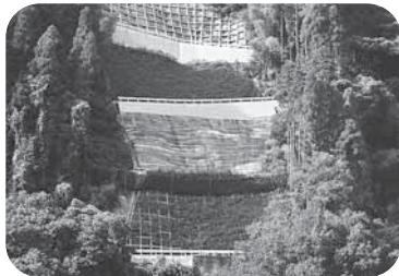
【災害復旧が完了した町道辻線】
