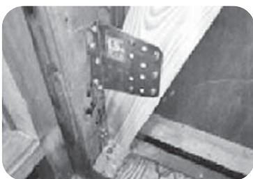
【柱と筋交とを補強する金物の設置】
