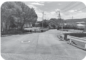
【北早川に設置した耐震性貯水槽】
