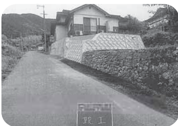
【被災宅地復旧工事が完了した宅地擁壁】
