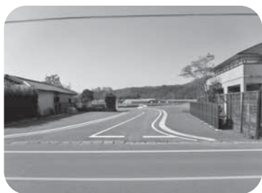
【大町集落までの一部を供用開始した町道仁田子古川線】
