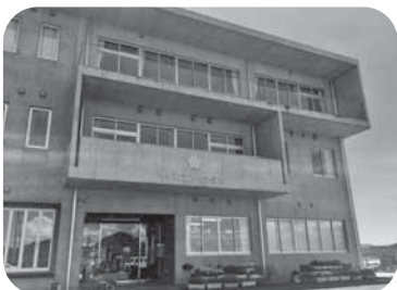
【地方債を活用して整備した 甲佐中学校正面玄関風景】
