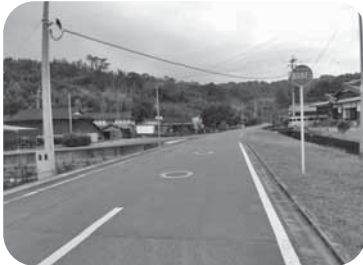
【下豊内地区の防火水槽設置状況】
