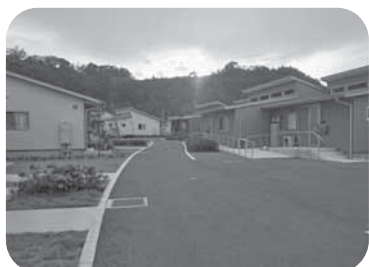
【甲佐地区に整備した災害公営住宅】
