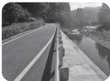
【災害復旧が完了した町道西寒野小川島線】
