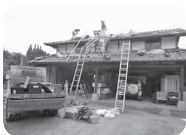
【震災で破損した農業用倉庫の改修の様子】
