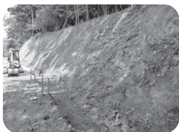
【林道山上幹線の災害復旧工事の様子】
