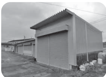
【岩下地区第二庁舎横の防災倉庫】
