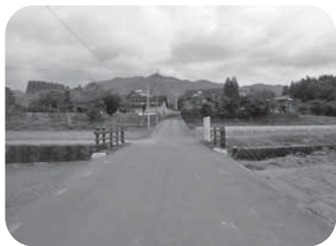
【補修工事が完了した上知行橋(上早川地内)】
