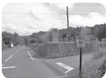
【更新した第二配水池 テレメータ施設】
