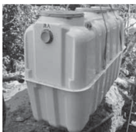
【合併処理浄化槽の設置工事の様子】
