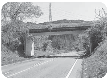
【国道443号を跨ぐ農道西幹線跨道橋】
