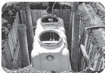
【合併処理浄化槽設置工事の様子】
