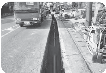
【令和2年度に実施した県道宇土甲佐線の水道管布設状況】
