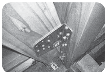
【住宅耐震化改修例(筋かい金物補強)】
