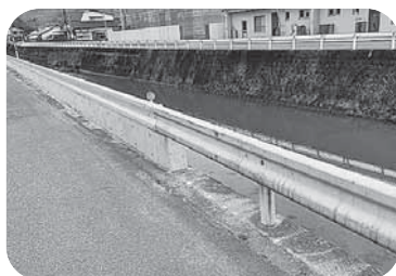
【竜野川護岸嵩上げの施工写真】
