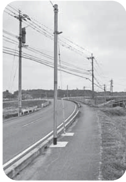
【整備された防犯灯(西寒野地区)】
