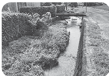
【普通河川内田川の現況写真】
