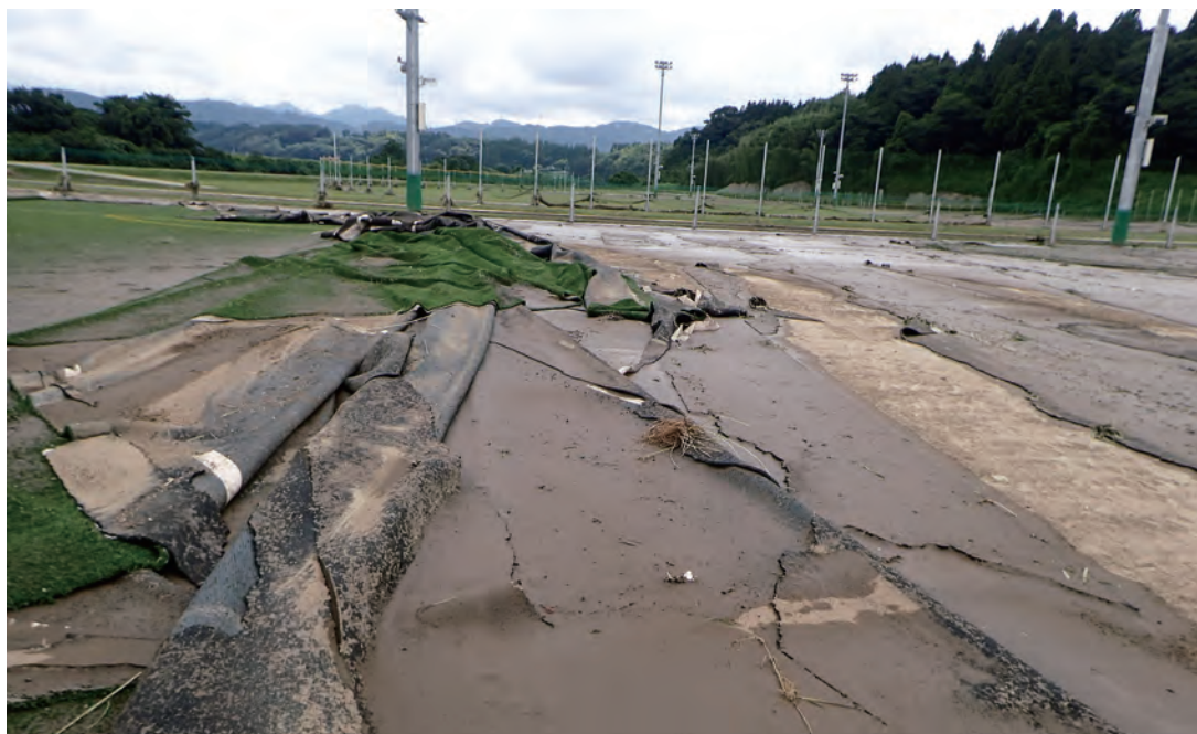
▲大雨による浸水害で、人工芝がはがれた熊本甲佐総合運動公園サッカー場
