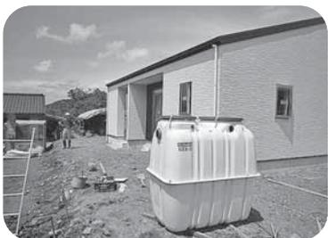
【一般家庭に設置される合併処理浄化槽】
