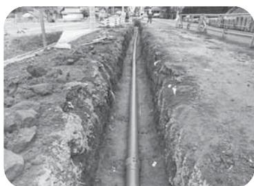
【令和4年度に実施した町道西寒野打越線の水道管布設状況】
