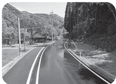
【町道上揚井戸江線改良完成写真】
