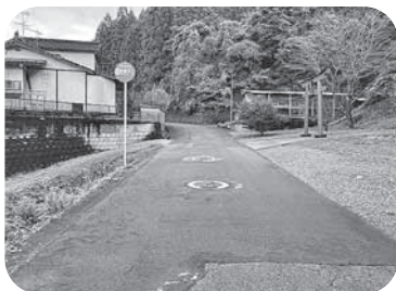
【東寒野地区の耐震性貯水槽】
