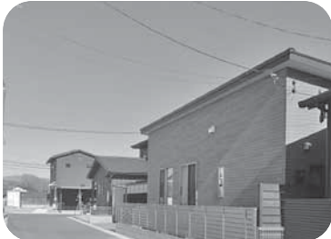
【住宅が建ち並ぶ住宅団地の風景】
