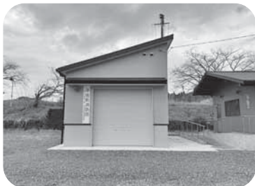
【建て替えた北早川地区消防格納庫】
