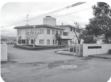
【御船地区衛生施設組合】
