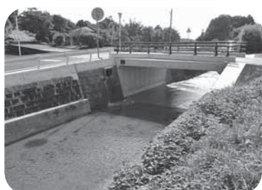
【町道幸野線・幸野橋完成写真】
