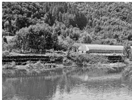
壊れた堤防と冠水した農業用施設
