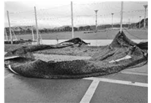
浸水によりめくれた人工芝
