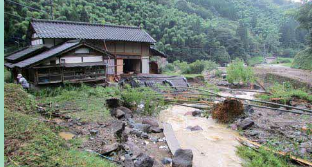
▲平成28年6月豪雨災害で被害を受けた宮内地区の家屋
