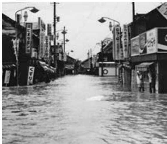
昭和47年 大雨による市街地の冠水
