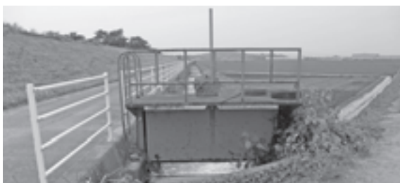
農業農村整備事業で改修予定の元白旗地区にある用水路のゲート
