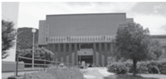
完成した中学校屋内運動場
