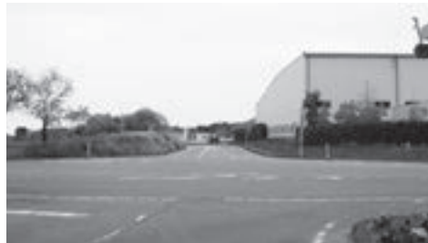
町道「南三箇中山線」の終点部付近
