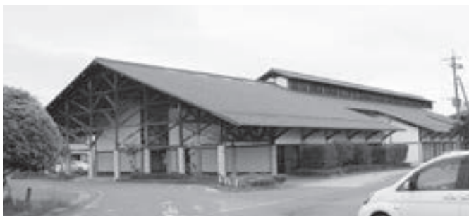
避難施設の機能強化として、太陽光発電施設設置が予定されている総合保健福祉センター（鮎緑）
