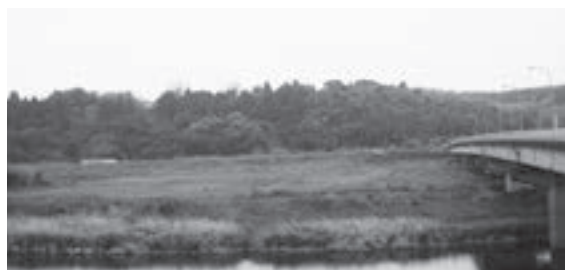
グラウンド等の整備が計画されている安津橋上流
