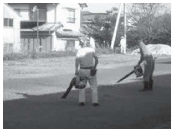
シルバー人材センターによる作業風景
