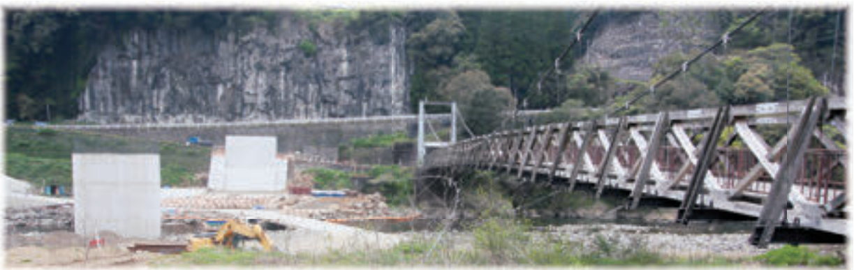
工事が進む町道「上揚井戸江線」
