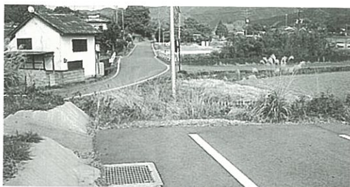
県道稲生野甲佐線（橋梁部）
