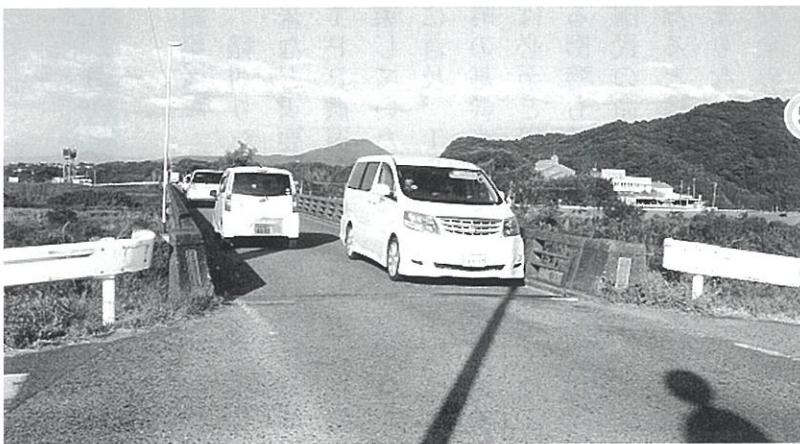
早期改修が望まれる田口橋
