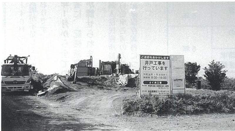
乙女台地のさく井工事
