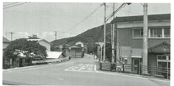
町道大町塔ノ木線
