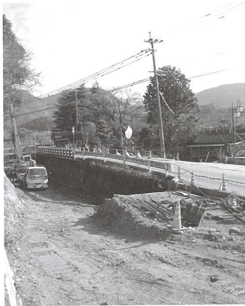
やな場の改修と県道の工事
