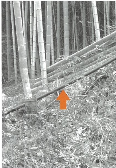
簡易水道の導水管（宮内広瀬地区）
