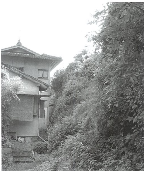
急傾斜地崩壊対策事業が実施される六谷地区
