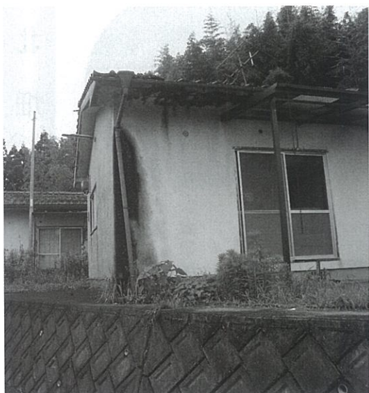
解体される旧教職員住宅
