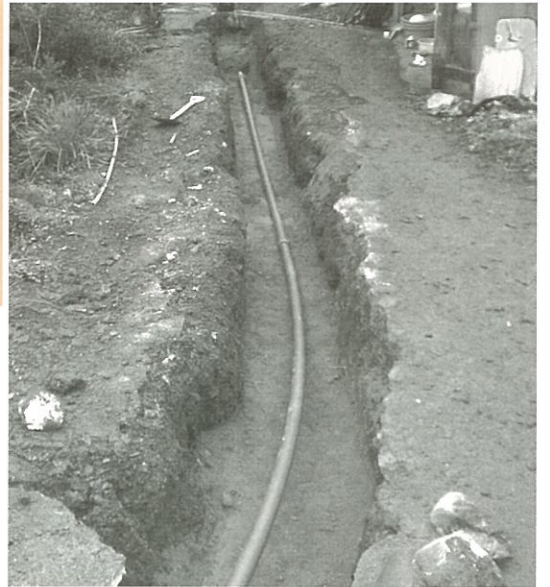
水道の老朽管布設工事
