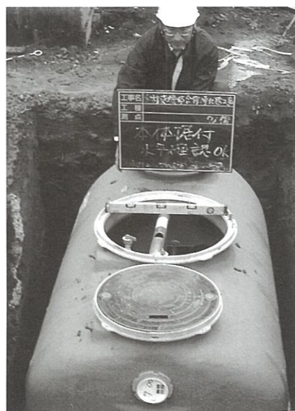
合併浄化槽設置工事
