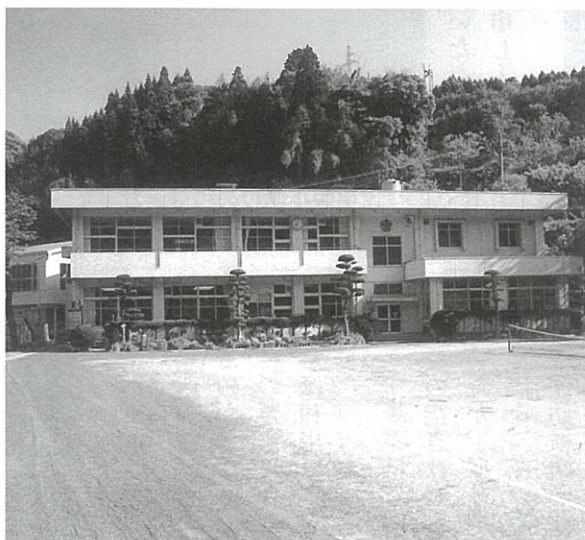
宮内地区社会教育センターとなった元宮内小学校
