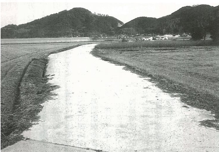
原材料支給による農道舗装
