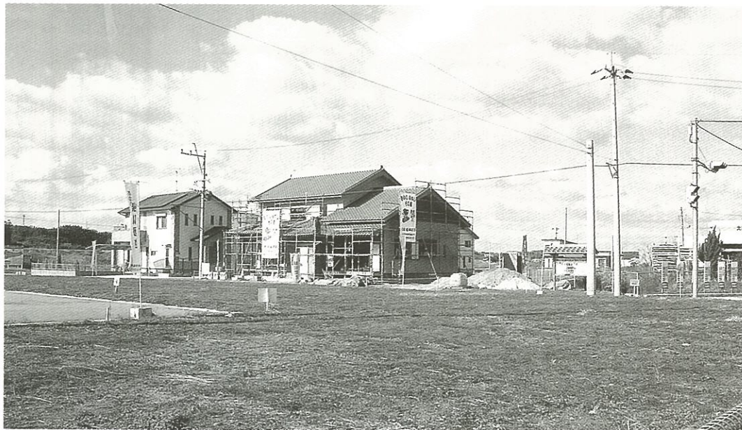
建築が進む緑川団地
