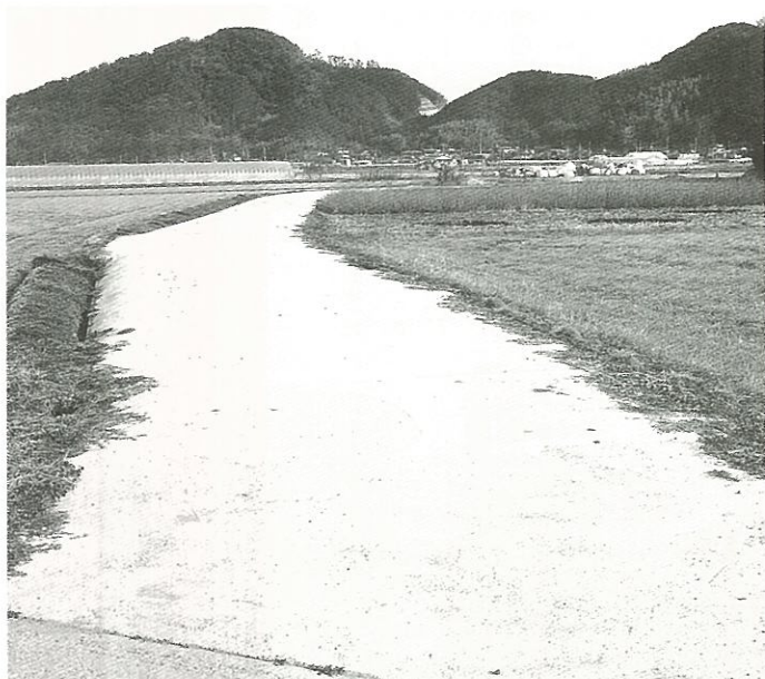
原材料支給による生コン舗装
