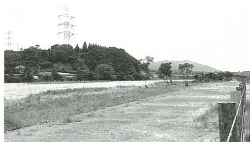
上揚地区の堤防工事区域
