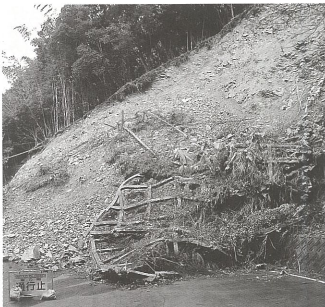
林道山上幹線の災害現場
