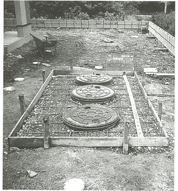
設置中の合併浄化槽
