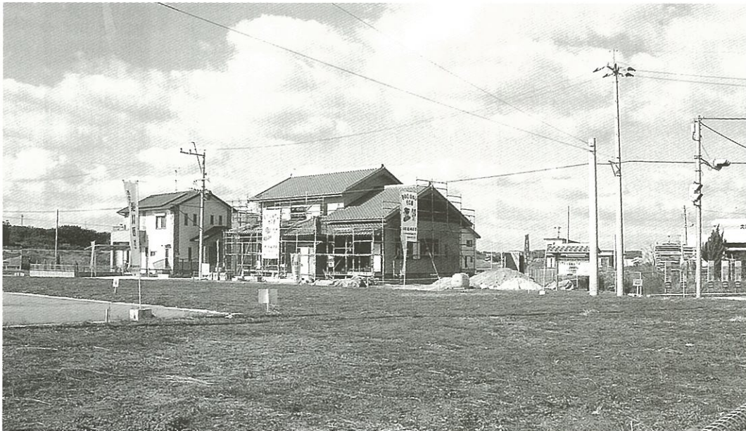
建築が進む緑川団地
