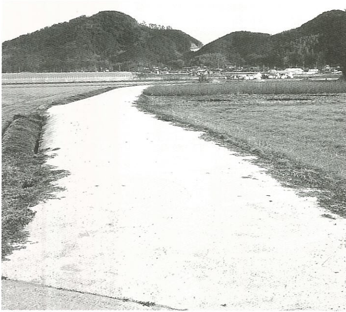
原材料支給による生コン舗装
