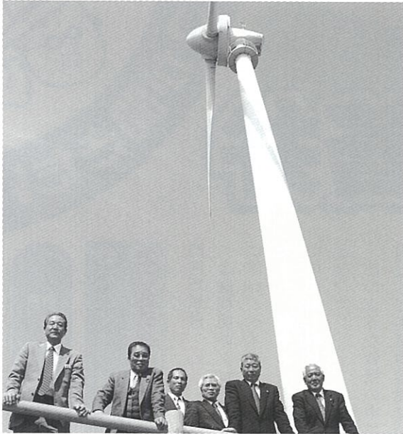
長島町の風力発電所
