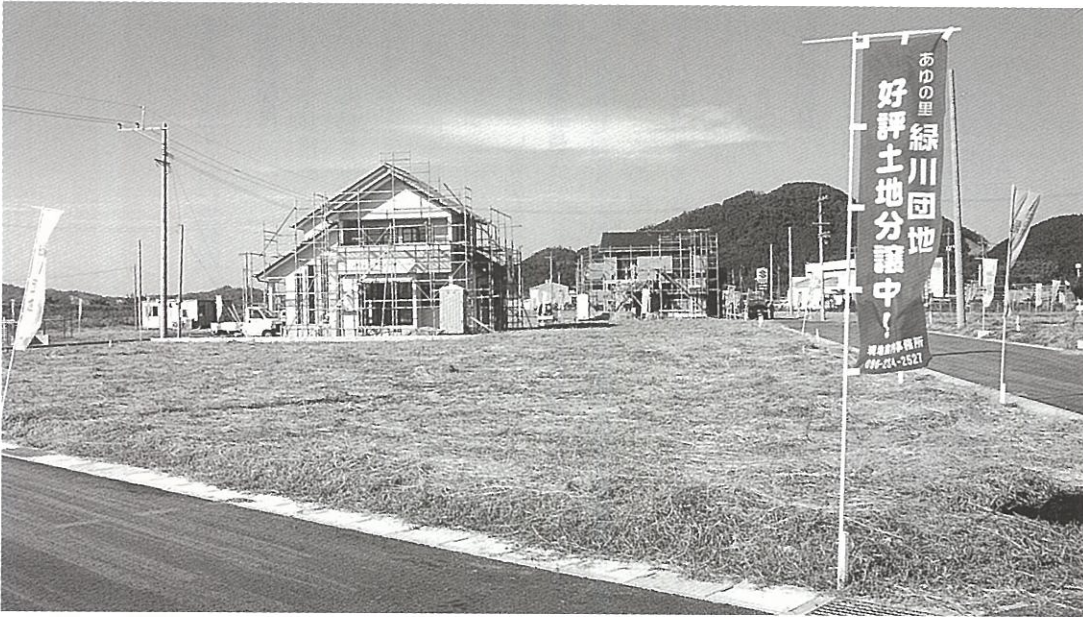
着々と建築が進む「あゆの里・緑川団地」
