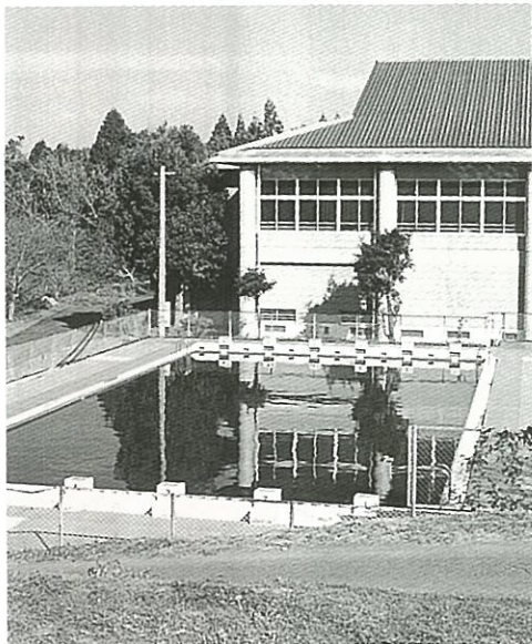
老朽化し、早急な改修が呼ばれる乙女小プール
