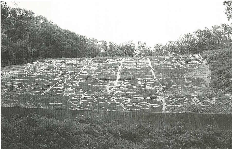
過去30年の焼却灰の処分場埋立地
