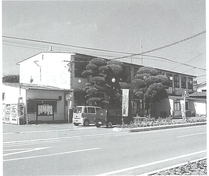
築後49年が経過した役場庁舎
