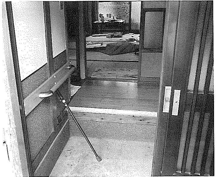
廊下の段差解消と手すり取り付けられた高齢者住宅
