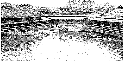
厨房や駐車場の整備が終わった「やな場」
