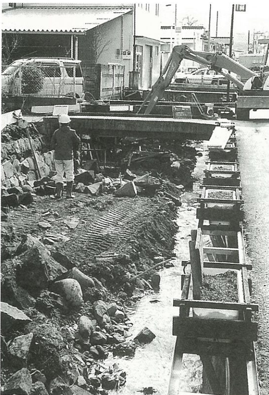
改修が進む大井手
