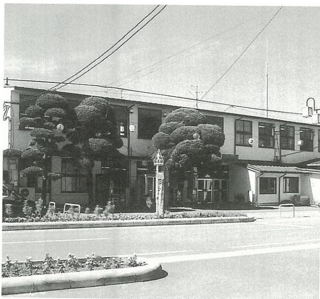
建築後47年が経過した役場庁舎
