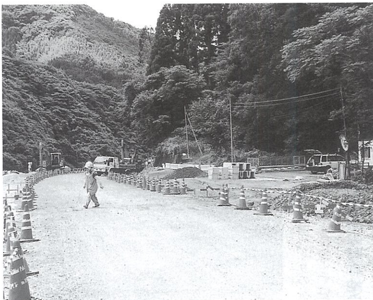
県道三本松甲佐線改良工事現場
