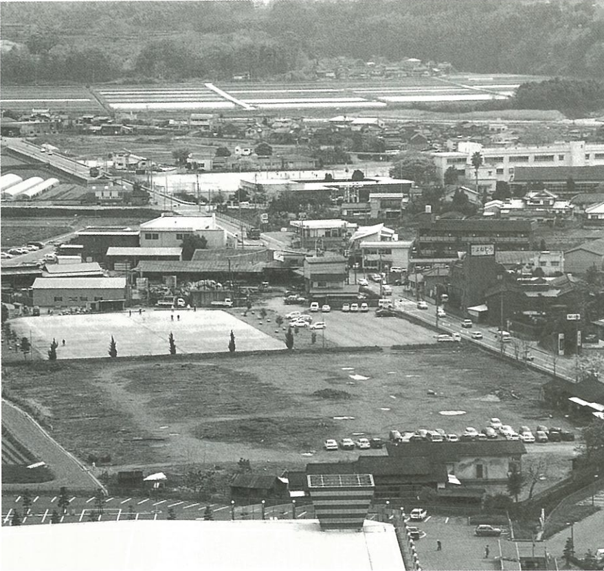
新庁舎の建設が決まった多目的運動広場
