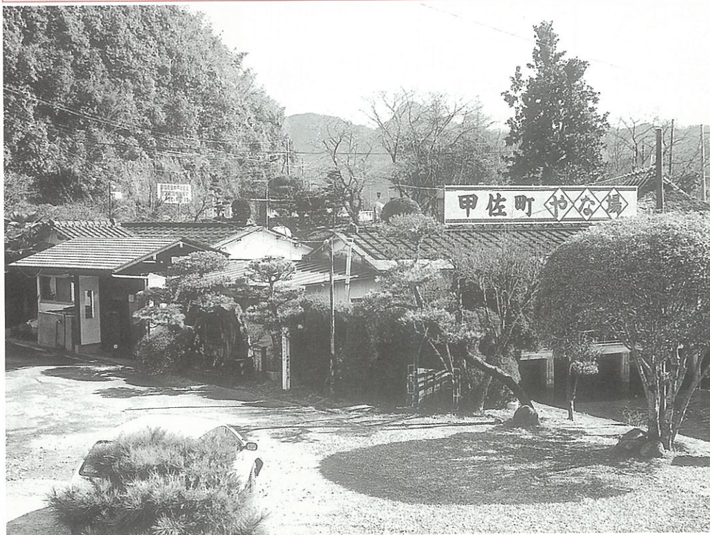
合併浄化槽、厨房などの改修を計画中の“やな場”
