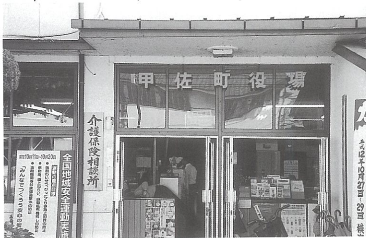
見慣れた役場庁舎。新築の時期はいつか
