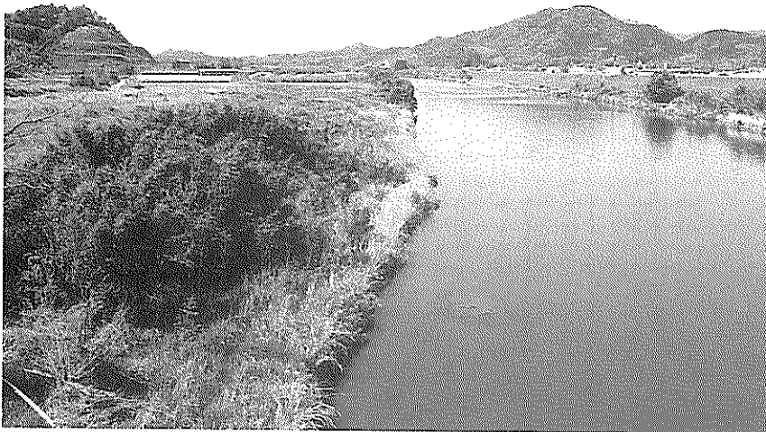
建設省と町での整備が間近い安津橋下流域
