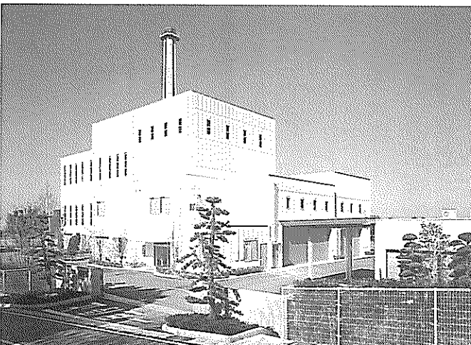
ダイオキシン対策が必要なクリーンセンター
