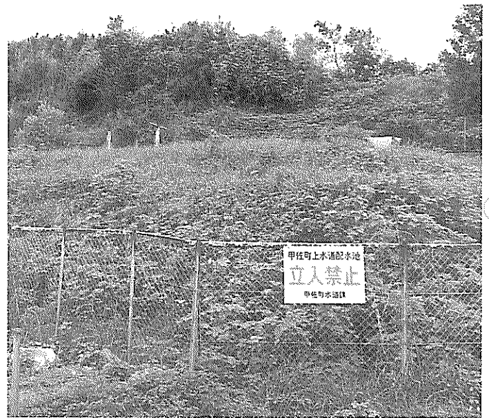
漏水調査が実施された上水道 上豊内配水タンク
