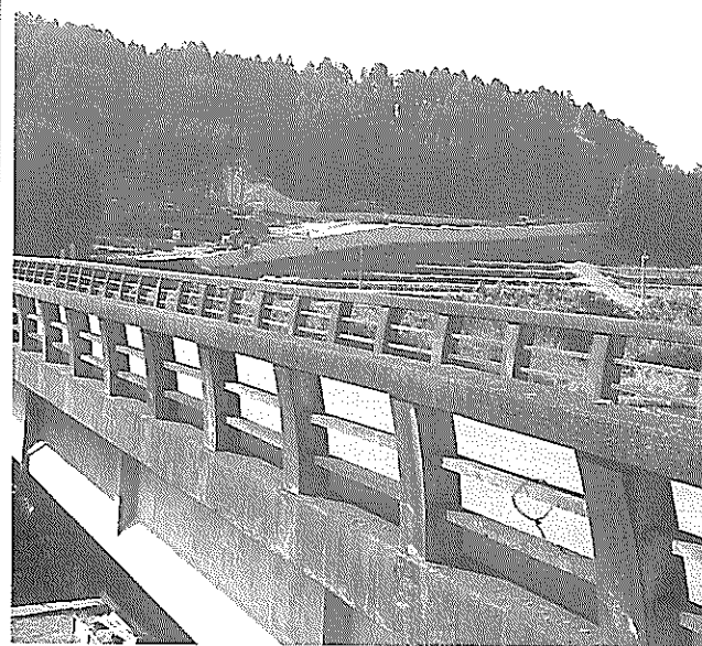
県代行事業で改良されている中央町
