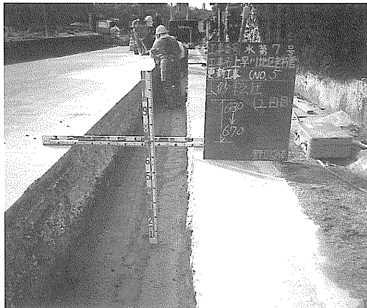
老朽管更新事業が進められる上早川地内
