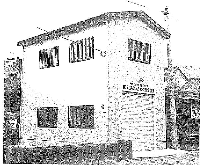
本年 3 月に完成した岩下消防格納庫
