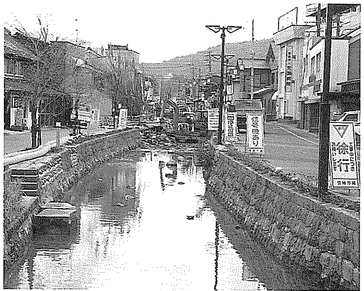
県営事業として着々と工事が進められている大井手川 (岩下一区・緑町地内)
