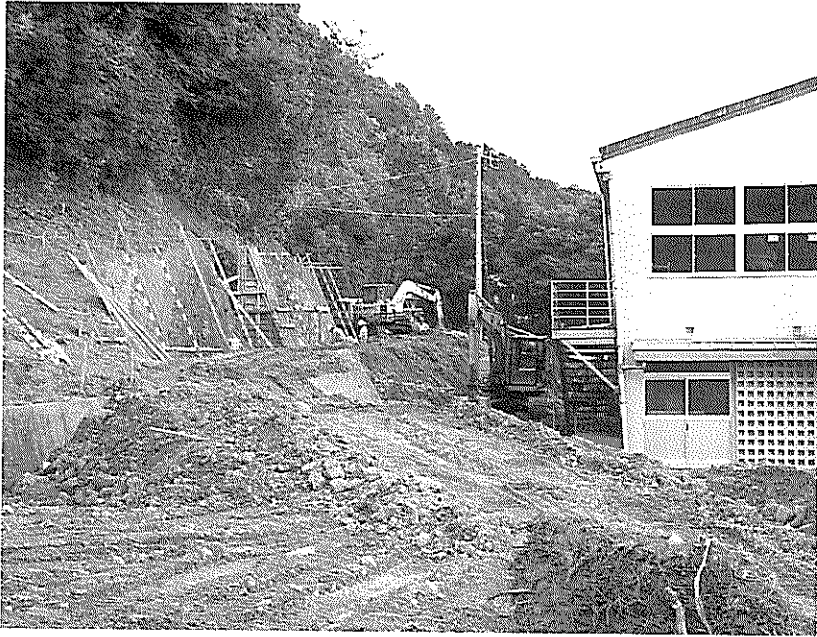
前年度よりの繰越事業で改良が進む町道辺場山道線
