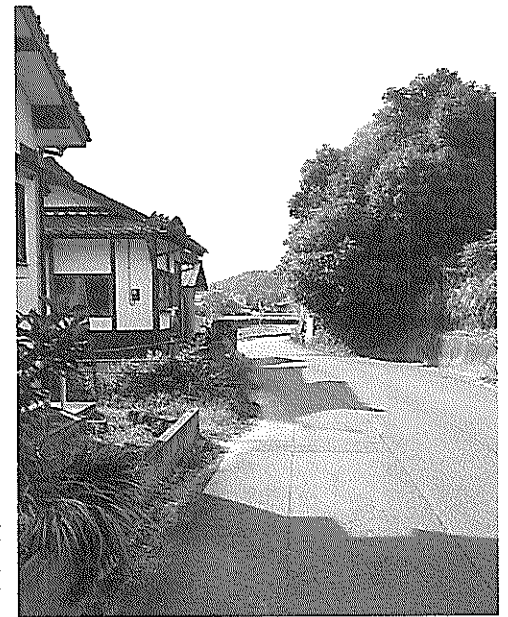
早期着工がのぞまれる町道塔ノ木城平線
