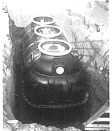
小型合併浄化槽設置工事状況
