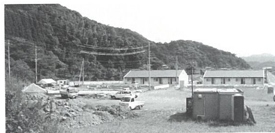
建設中の立岩団地
