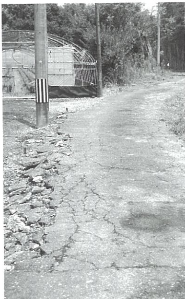
改良が望まれる町道迫防分線
