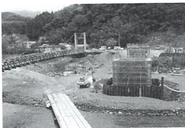
町道上揚井戸江線改良工事
