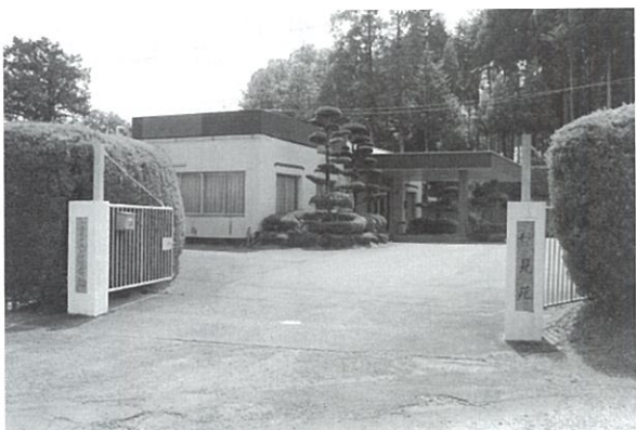
老朽化した火葬場
