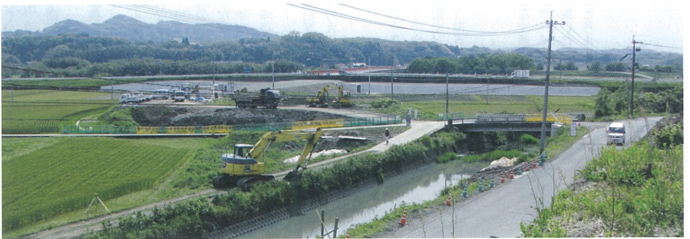
改良が進む町道松ヶ崎妙見谷線
