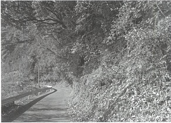
小鹿線の落石防護は
