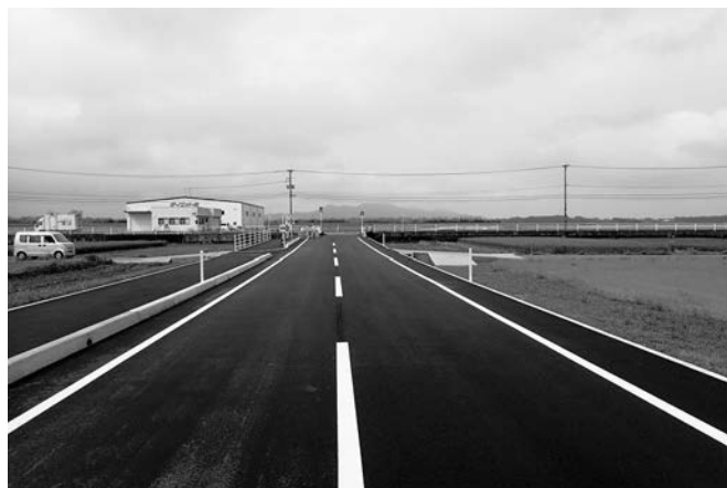
御船インターへのアクセス道路として車道の2車 線化と歩道の整備が進む町道山出県道線
