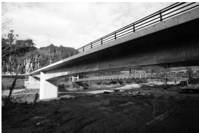
町道上揚井戸江線に架かる井戸江峡橋（仮称）は 県道三本松甲佐線の迂回路としての機能へ期待
