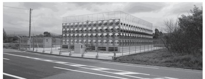
27年度に完成した第4配水池
