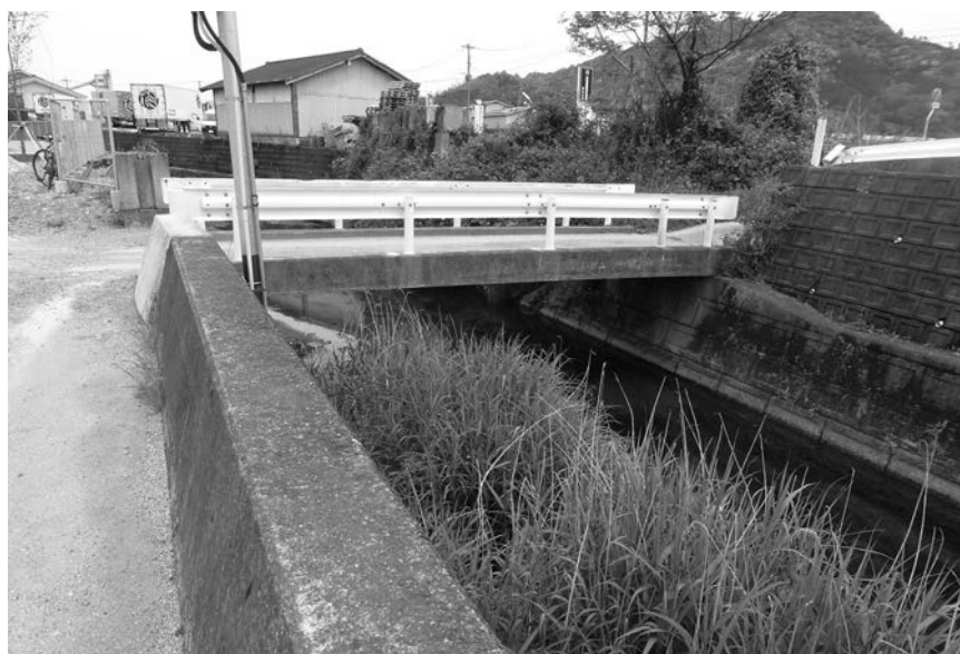
町村河川内田川に架かる橋梁（下横田地内）
