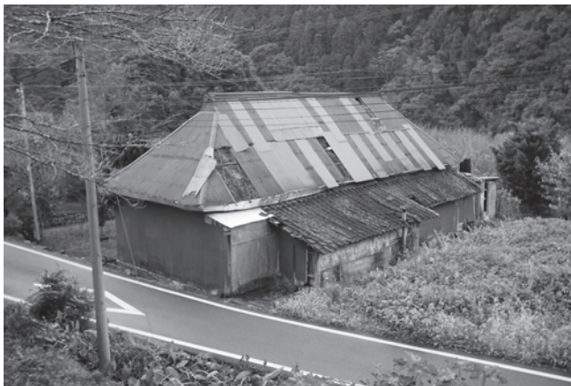
空き家状態となっている家屋
